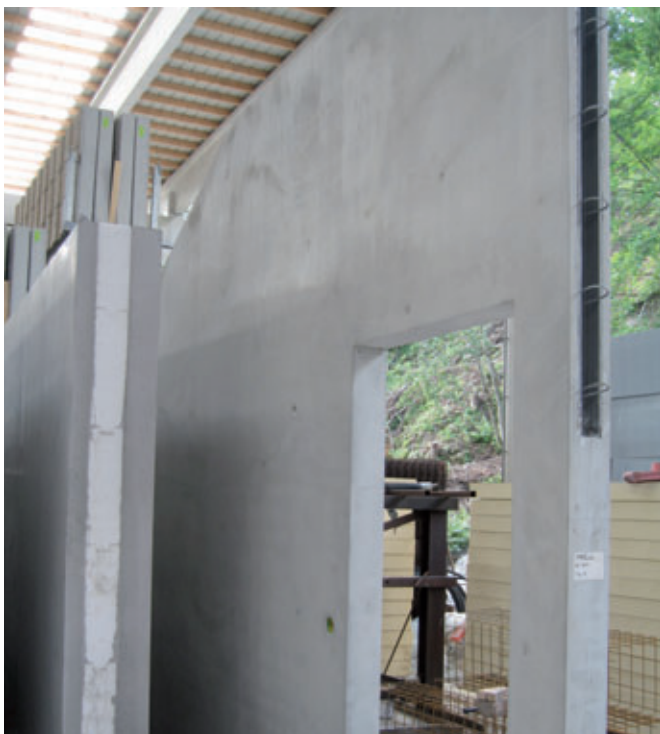
Abb. 7: Sandwichwand und Massivwand – beide mit der Upcrete-Technologie produziert
