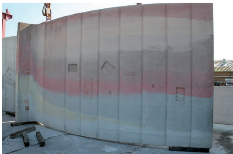
Abb. 9: Gekrümmte Wand, die mit unterschiedlich farbigen Betonen mit der Upcrete-Technologie betoniert wurde
